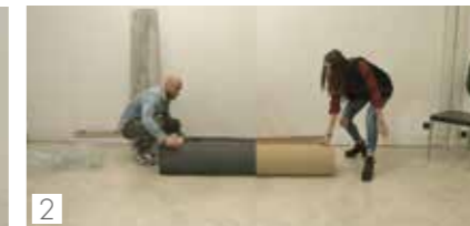
2 Stendere il tappetino Lay the underlayer
