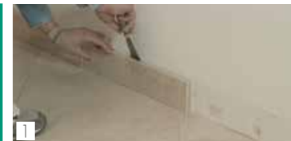
1 Eliminare il battiscopa Remove skirting
