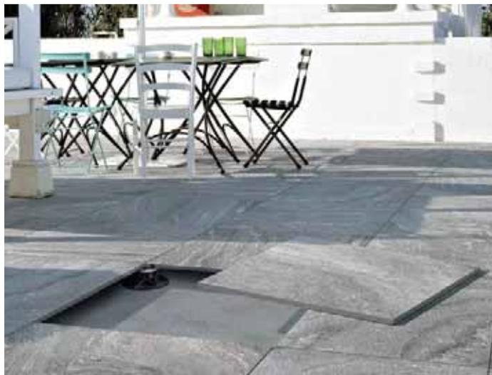
**POSA FLOTTANTE** (terrazze, solai, balconi, ambienti esterni sottoposti a camminamento pedonale)
